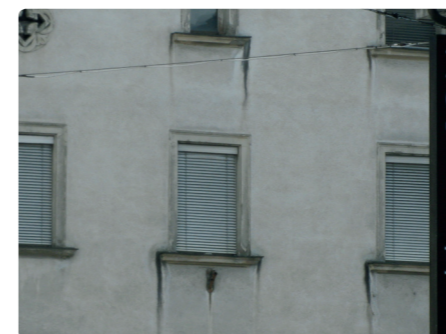
Figur 3. Skittstriper pga uheldig manglende sideoppbrett på sålbenken.
