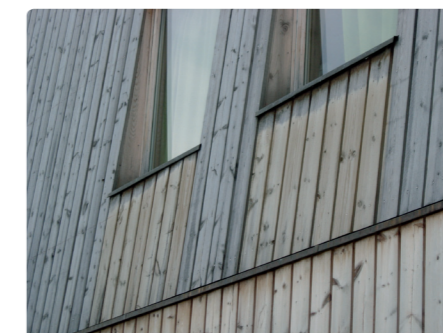
Figur 6. Eksempel på uheldig materiale brukt på beslaget. Kobberbeslag sammen med ubehandlet trekledning fører til at trekledningen under beslagene ikke grånes slik resten av kledningen siden kobberionene trolig dreper svertesoppen som skal gi gråfargen.
