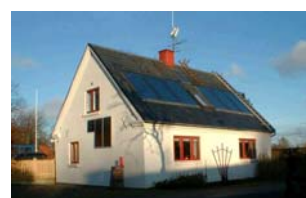
Solfangere installert i ulike boliger
