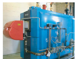
Kondenserende gasskjeler i ulike kapasitetsklasser
