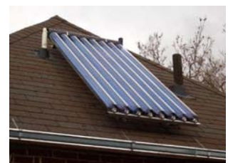
Solfanger med vakuumsolfanger
