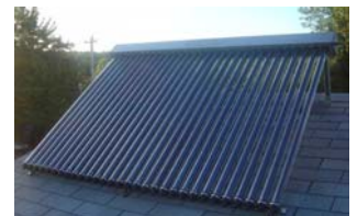
Solfanger med vakuumrør
