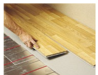
Elektriske varmekabler i tregulv
