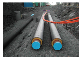
Preisolerte fjernvarmerør
