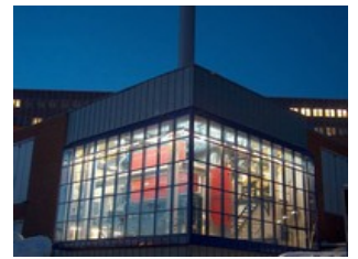
Breivika varmesentral i Tromsø fyres med bioenergi (29 MW)
