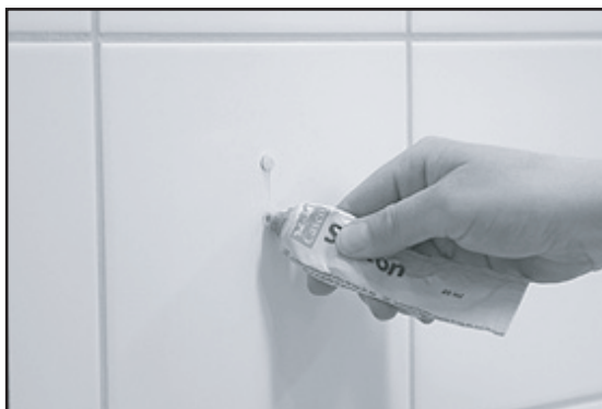
[ Bild 4.] VIKTIGT! Våtrumssilikon i pluggen och runt hålet.
