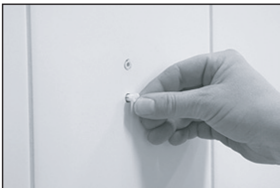
[ Bild 3.] Montera plastplugg avsedd för 5.5mm hål.
