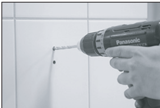
[ Bild 2.] 7 mm borrar endast genom kakel (använd kakelbollar) Applicera våtrumssilikon i hålet.
